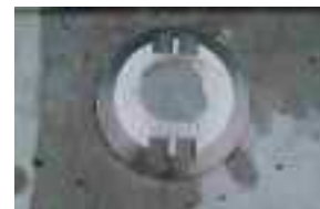
写真 3-3.1 電位測定端子
