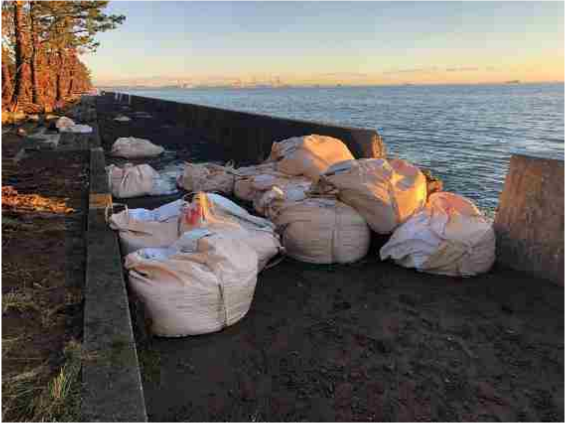
図－2 金沢区福浦地区土嚢の飛散状況
