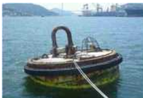
写真 3-6.3 係船浮標の外観
