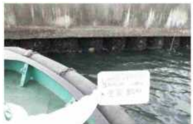
（海上目視調査の点検状況）
