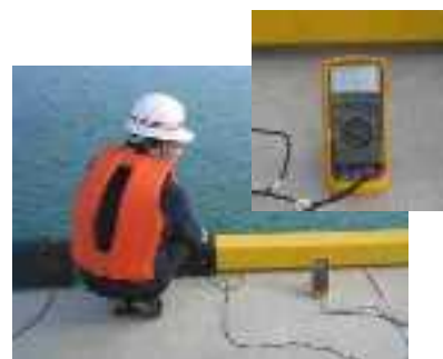
写真 3-3.2 電位測定状況
