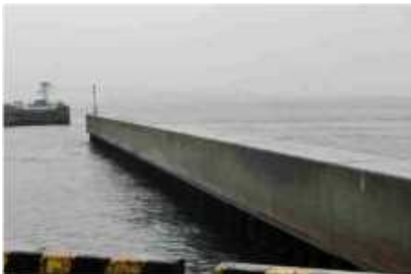
（陸上目視の点検状況）
