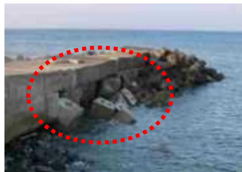
(コンクリートブロックの抜出し)
